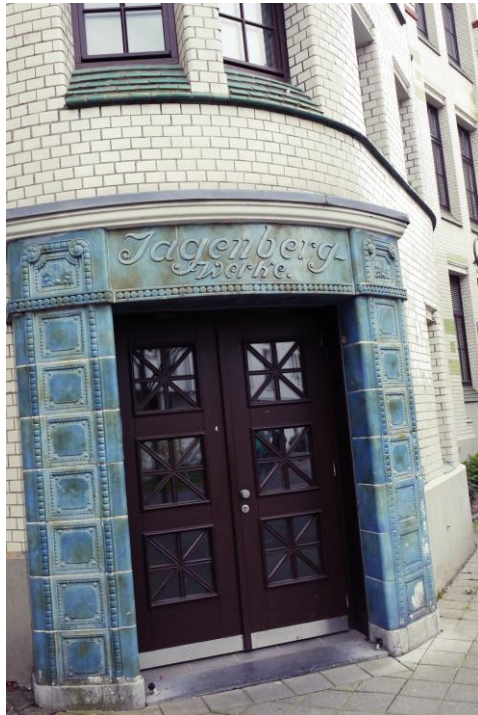
Eingangstüre Himmelgeister Straße
